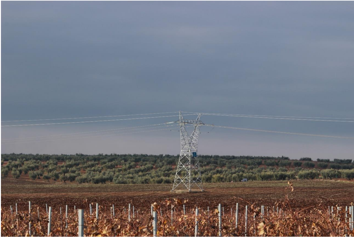
Figura 1. Presencia de tendidos eléctricos en los terrenos. Fuente: Elaboración propia
